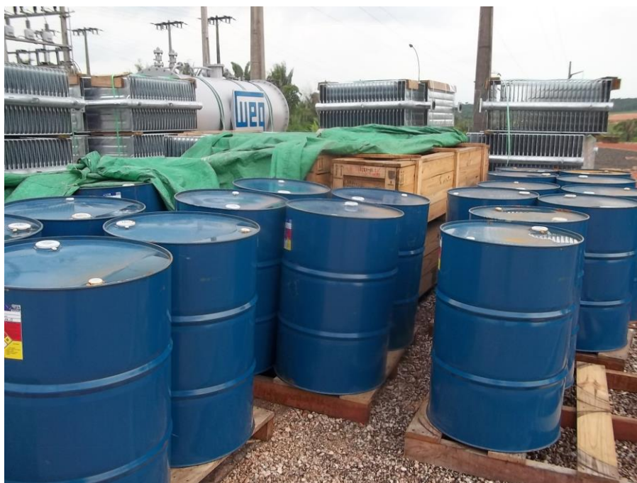
Figura 18 – Óleo mineral isolante em tambores de 200 litros.
