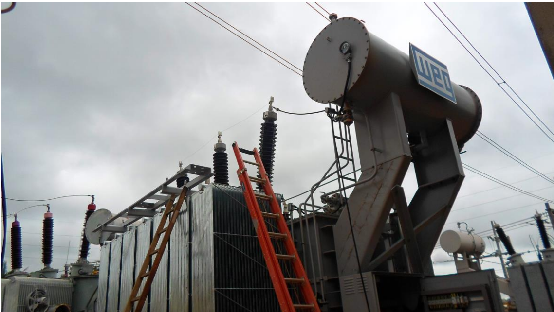
Figura 1 – Exemplo ilustrativo de transformador de potência.
